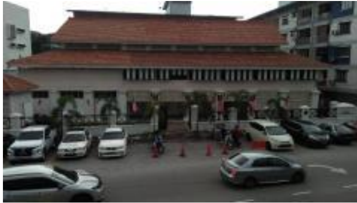
Gambar 1: Keadaan terkini bangunan Gedung Raja Abdullah setelah selesai kerja-kerja baik pulih.
