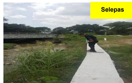
Muara Sungai Rasah, Klang - Pemasangan Capping Beam Menjadikan Wellguard Mengikut Jajaran Sungai (19.01.2018)
