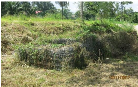
Sungai Kedondong, Daerah Petaling - MSE Wall System yang Terbiar dan Rosak di Tapak Bina (13.11.2017)
