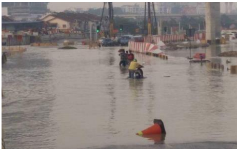
Plaza Tol Sungai Rasah - Kejadian banjir (07.11.2017)
