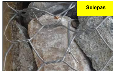
Sungai Pelempas, Kampung Melayu Subang - Sangkar Gabion yang Telah Dibaiki (19.01.2018)
