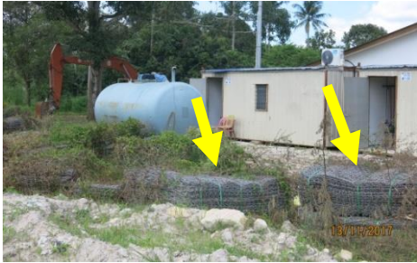
Sungai Kedondong, Daerah Petaling - MSE Wall System yang Terbiar dan Rosak di Tapak Bina (13.11.2017)
