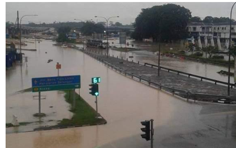
Jalan Batu Tiga Lama, Shah Alam - Kejadian Banjir (07.11.2017)
