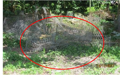
Sungai Kedondong, Daerah Petaling - MSE Wall System yang Terbiar dan Rosak di Tapak Bina (13.11.2017)
