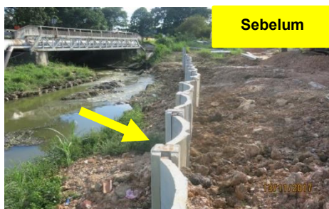
Muara Sungai Rasah, Klang - Wellguard Dipasang Tidak Lurus (13.11.2017)
