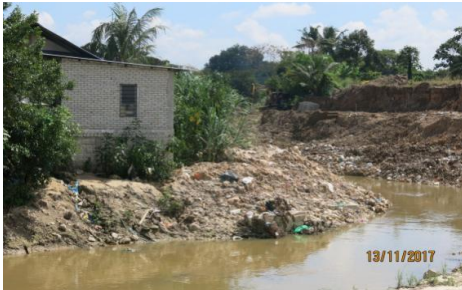
Sungai Pelempas, Kampung Melayu Subang - Halangan Rumah di Jajaran Sungai (13.11.2017)
