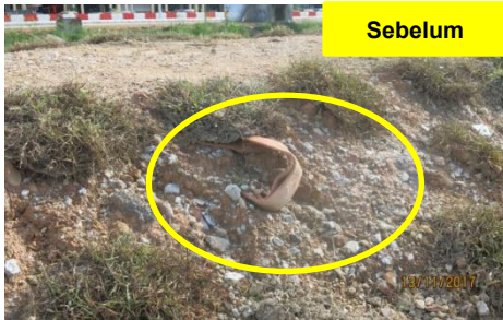
Sungai Rasah, Taman Rashna - Unsuitable Material di Dalam Ban (13.11.2017)
