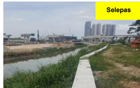
Muara Sungai Rasah, Klang - Capping Beam Telah Siap Dibina (19.01.2018)
