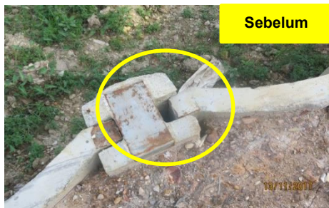
Muara Sungai Rasah, Klang - Slot Panel Wellguard Tidak Dipasang Dengan Kemas (13.11.2017)
