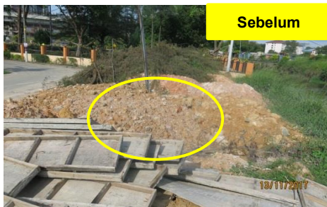
Sungai Rasah, Taman Rashna, Klang - Tanah Ban/Benteng yang Tidak Dipadatkan (13.11.2017)
