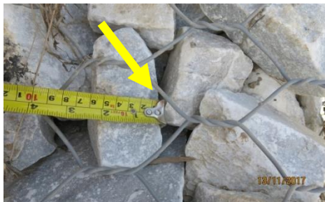
Sungai Pelempas, Kampung Melayu Subang - Saiz Batu Gabion yang Kecil 50mm (13.11.2017)
