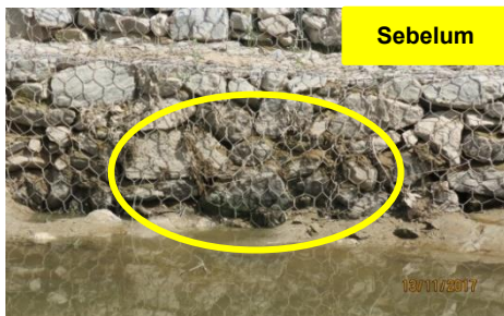
Sungai Pelempas, Kampung Melayu Subang - Sangkar Gabion Mendap (13.11.2017)
