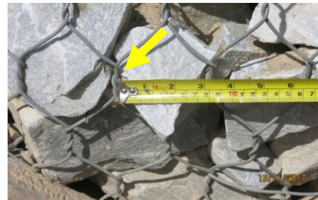
Sungai Pelempas, Kampung Melayu Subang - Saiz Batu Gabion yang Kecil 80mm (13.11.2017)
