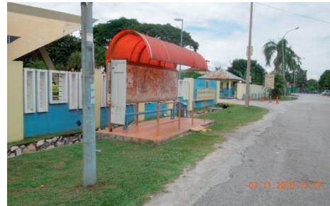
Hentian Stadium Serdang Jaya, Serdang - Tiang Tidak Disediakan (07.11.2018) (Sumber: Jabatan Audit Negara)
