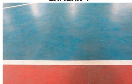
Sekolah Menengah Kebangsaan Jenjarom, Banting - Lantai Dibuat daripada Getah (16.01.2019) (Sumber: Jabatan Audit Negara)
