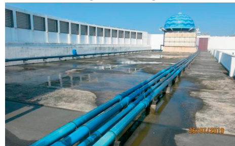
SACC - Kawasan Aras Bumbung yang Dipenuhi Lumut Akibat ABS Pipe yang Bocor (26.07.2019) (Sumber: Jabatan Audit Negara)
