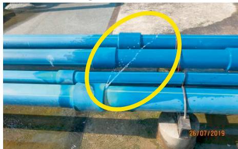
SACC - ABS Pipe yang Bocor di Tingkat Aras Bumbung (26.07.2019) (Sumber: Jabatan Audit Negara)
