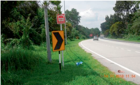
Hentian Desa Rening, Hulu Selangor - Kedudukan Tiang di Selekoh dan Tiada Maklumat Laluan (14.11.2018) (Sumber: Jabatan Audit Negara)
