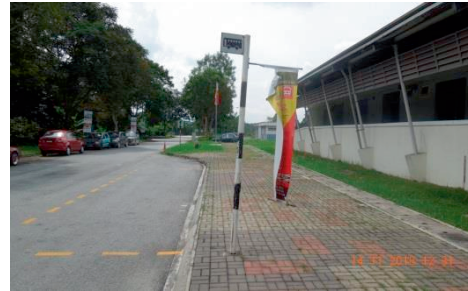
Hentian KTM Batang Kali, Hulu Selangor - Maklumat Laluan Pada Tiang Rosak (14.11.2018) (Sumber: Jabatan Audit Negara)
