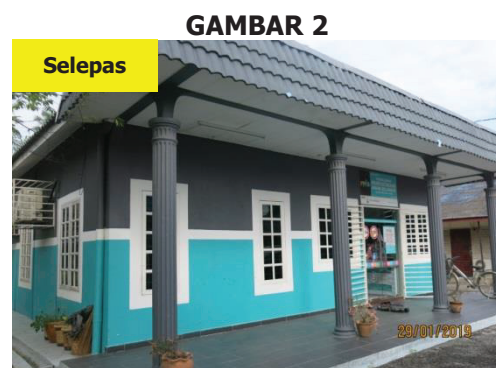
Perpustakaan Desa Sijangkang, Kuala Langat - Bangunan Selepas Dinaik Taraf (29.1.2019)
