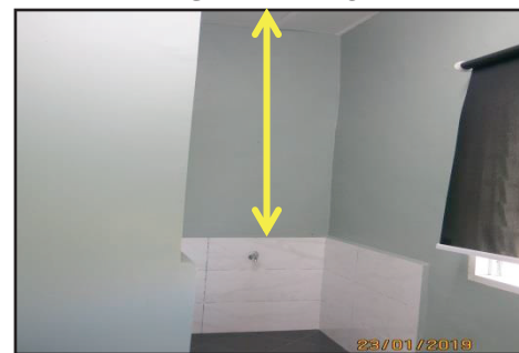
Perpustakaan Desa Bagan Terap, Sabak Bernam - Jubin Dinding Tempat Wudhu Berharga RM1,560 Tidak Dibekalkan Sehingga Aras Siling (23.1.2019)
